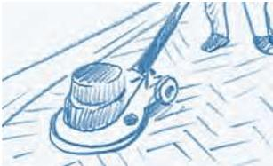
3. Nach einer Trockenzeit von ca. 30 Minuten muss die Fläche mit einer Einscheiben-Poliermaschine mit weißem Pad oder einem groben Baumwolltuch nachpoliert werden. Eine Nachbehandlung mit Wasser darf auf gar keinen Fall erfolgen.
