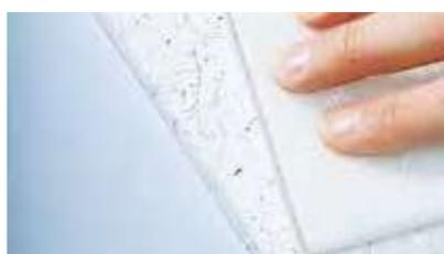
**6.** Eventuell entstandenen Sprühnebel mit feiner Stahlwolle (000) oder weißem Schleifvlies entfernen. Hierbei mit wenig Druck arbeiten, um keine Schleifspuren zu verursachen.
