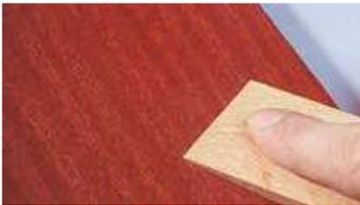
2. Achten Sie darauf, dass Sie das Weichwachs fest mit einem Spachtel in den Kratzer drücken. Nun nehmen Sie das überschüssige Weichwachs ab. Bitte keine scharfkantigen Spachtel verwenden, da diese die lackierte Oberfläche beschädigen. Um alle Reste zu entfernen, können Sie die Fläche noch mit dem weißen Schleifvlies abreiben.
