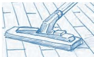
1. Bevor Sie mit der Versiegelung beginnen, müssen Sie den Staub vom Schleifen beseitigen. Stauben Sie Bilderrahmen, Fensterbänke, Türzargen usw. ab und saugen Sie den Fußboden gründlich. Anschließend wischen Sie den Boden mit einem feuchten, sauberen Tuch (nebelfeucht).
