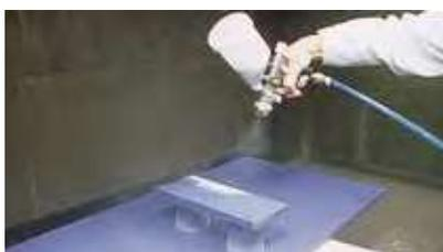
**6.** Jetzt wird die Fläche mit Wigranit® Novacolor 2K PUR Buntlack WNC lackiert. Bei Holzflächen würde hier die Endlackierung erfolgen.
