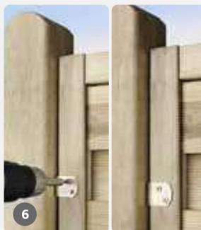
Setze nun die Zaunelemente ein und fixieren diese, nachdem Du die Schraublöcher vorgebohrt hast. Mit zwei Personen ist diese Arbeit, auch ohne Unterlegholz, einfacher zu meistern. Achte auf den gleichmäßigen Pfosten-/Zaunelementabstand von 1 cm, eine gleichmäßige Höhe und die passende Flucht der Zaunfelder.
