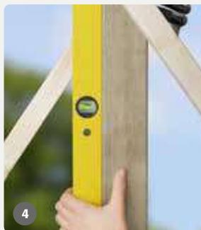
Mit einer Wasserwaage kontrollierst Du, ob die Pfosten im Lot stehen. Korrekturen sind solange möglich, bis der Beton abbindet. Achte daher auf die angegebenen Fixierzeiten auf der Verpackung. Entferne die Stützen und Hilfsmittel erst nach dem Aushärten des Betons. Erst jetzt kannst Du mit dem Anschrauben der Zaunelemente beginnen.
