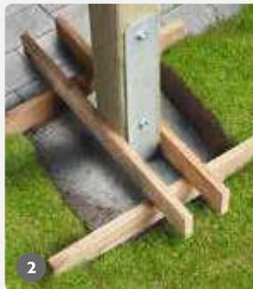
Als Montagehilfe mindestens 2 Latten an Pfostenende fest verschrauben. Lege nun zwei Unterleghölzer unter, damit Du Deinen gewünschten Abstand zwischen Erdboden und Pfosten erhalten. Setze den Pfosten inkl. Träger in das zuvor ausgehobene Fundamentloch (wir empfehlen eine Größe von 35 x 35 cm und 80 cm Tiefe).
